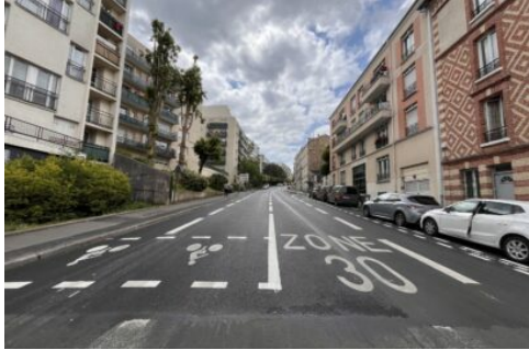
Bas de la route des Gardes et ses voies cyclables.
