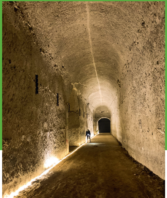
Haute galerie, au niveau intermédiaire, le long du front de taille, qui restera visitable après travaux.
