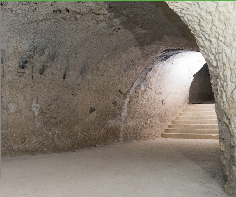
Accès aux galeries de grande hauteur préservé, au niveau - 2, le long du front de taille.
