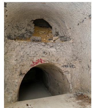
Débouché d'une faille karstique, préservé et accessible après travaux.
