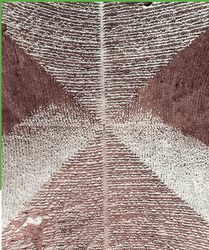
Croisée d'ogive en plein cintre, à l'intersection de deux galeries.
