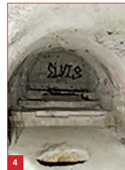
Intérêt historique Zone de refuge ou de repos des carriers, taillée dans la masse. Au premier plan, trou de communication avec l'étage inférieur.
