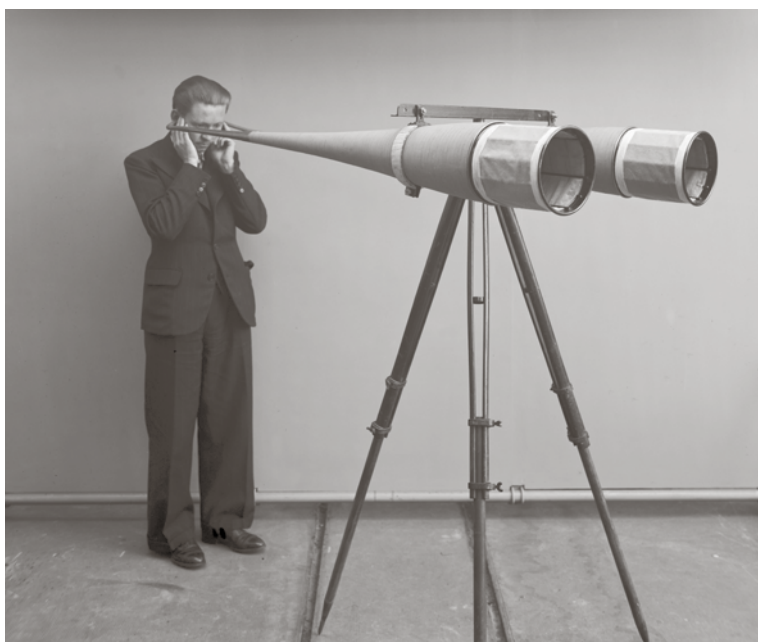
Georges Mabboux cherche à perfectionner les cornets acoustiques utilisés pour l'émission et la réception d'ondes sonores. Son amélioration est focalisée sur « l'écoute des bruits aériens de sources lointaines ». L'objectif est d'atténuer les distorsions des cornets, de réduire leur bruit de fond afin d'accroître leur efficacité. Le 20 mars 1934, Mabboux demande un brevet qui sera délivré le 1 er mai 1939. Entre-temps, les recherches sur le radar ont permis aux techniques de détection de franchir un cap, rendant ces « grandes oreilles » obsolètes et aux limites du fantasque. |
