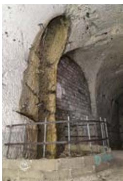
Ancien puits d'arrosage des galeries traversées par des eaux collinaires. Concrétion calcaire déposée sur les parois du puits.
