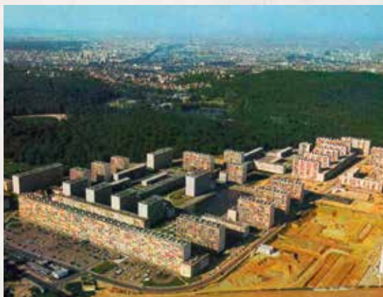
Les premiers immeubles livrés en 1961.
