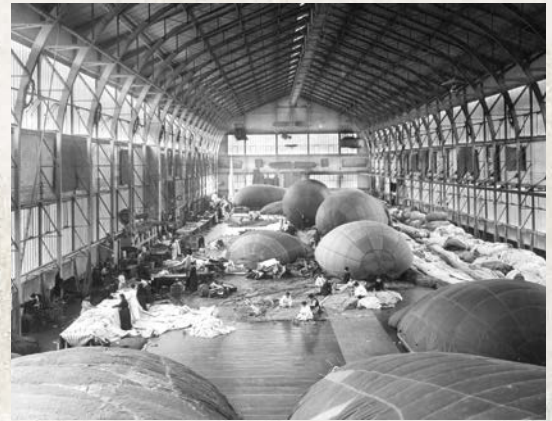
Fabrication des saucisses Caquot dans le Hall AT de Meudon.
